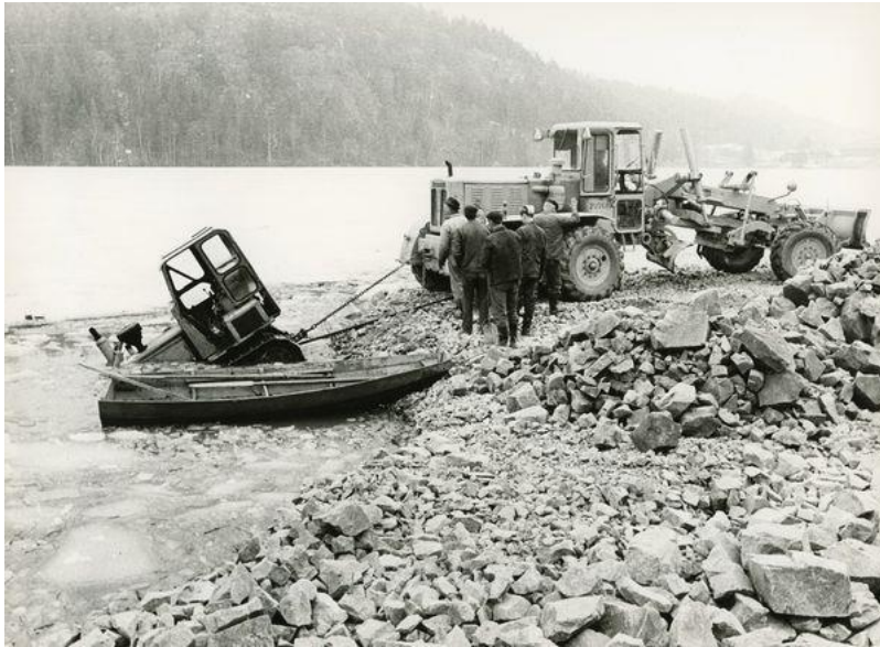
Gummetorpsjön under schaktningen för en Förbifart Kisa 1967
