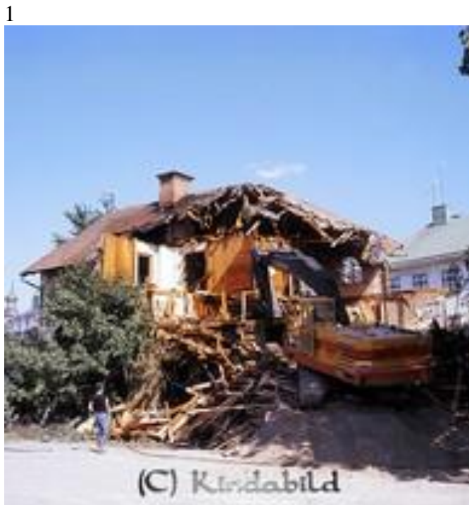
Rosenborg under rivning
