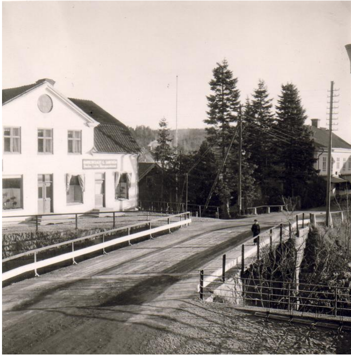
Så här såg bron vid Skoaffären ut före 1948. Tanken var att järnvägen skulle elektrifieras och att det skulle beredas plats för en elledning under bron. Någon elektrifiering blev det dock inte. Foto: Stig Sandström
