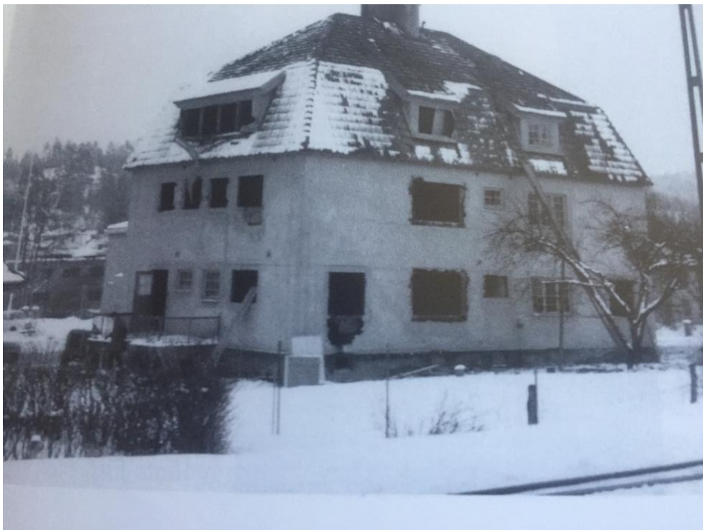
Järnvägarnas personalbostad vid rivningen ca 1965
