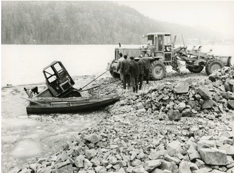
Gummetorpsjön under schaktningen för en Förbifart Kisa 1967
