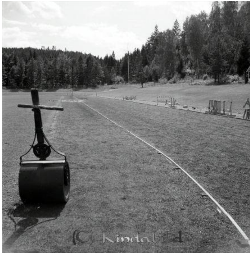
Byggnation av idrottsplatsen 1959
