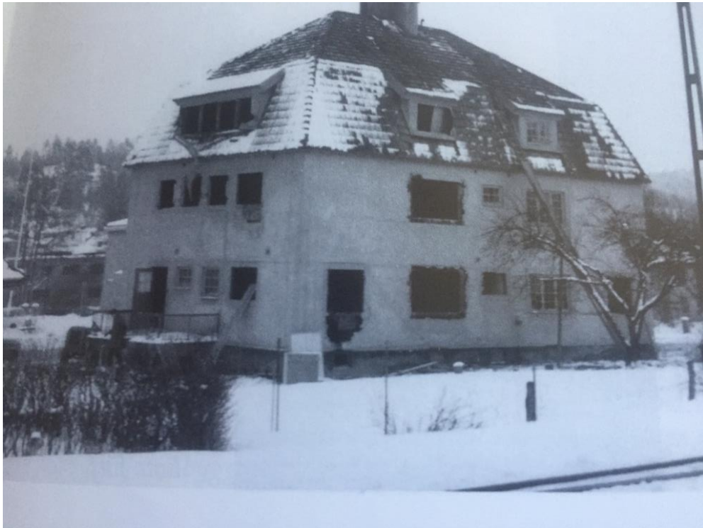
Järnvägarnas personalbostad vid rivningen ca 1965
