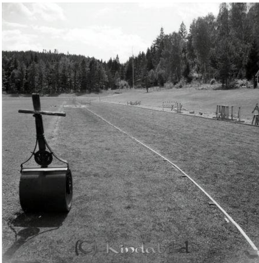
Byggnation av idrottsplatsen 1959
