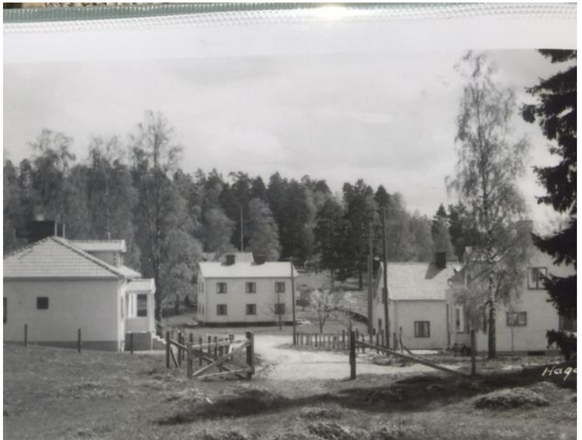
Före Linnégatan ca 1950. Här var det gästgivarens beteshage innan Kisahusen byggdes. Vy ner mot Västra vägen.
