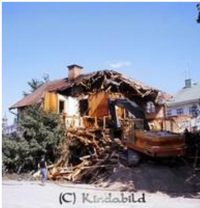
Rosenborg under rivning
