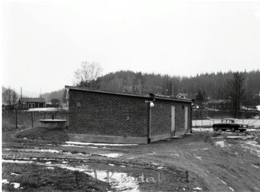
Vattenverket i Mjellerum 1961.
