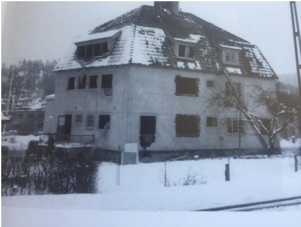
Järnvägarnas personalbostad vid rivningen ca 1965
