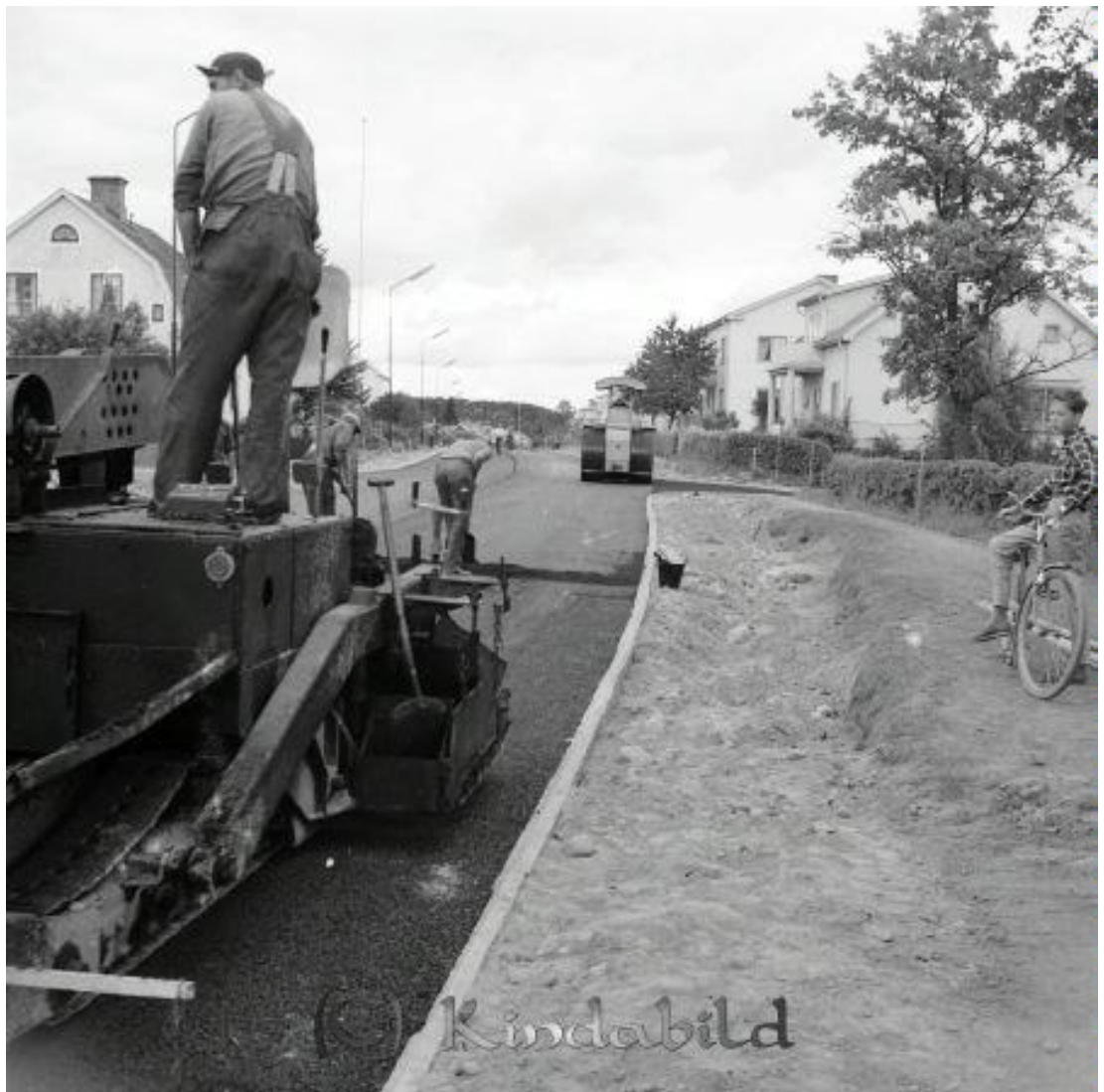
Asfaltering av Ulrikagatan 1959
